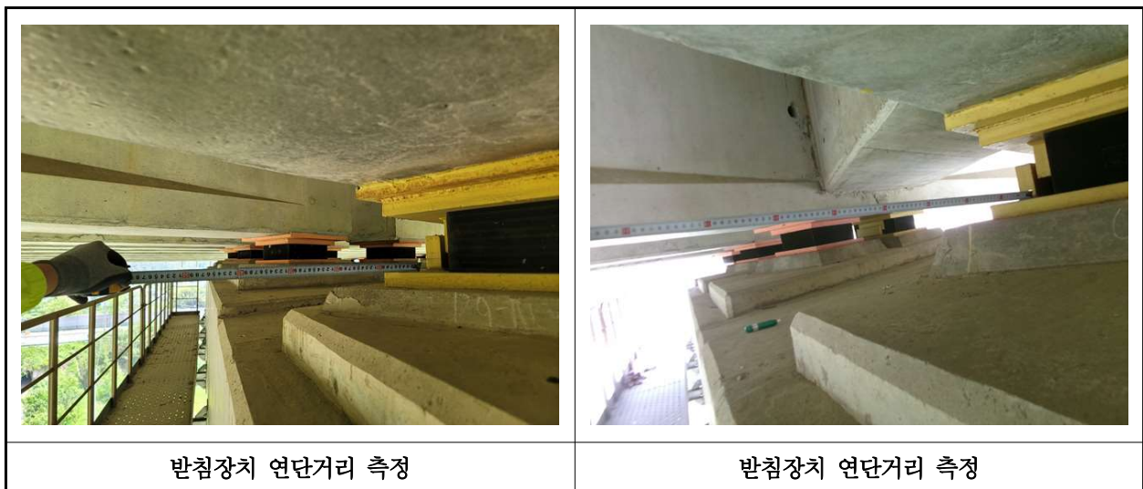
【사진 40.3.15】 교량받침장치 연단거리측정
