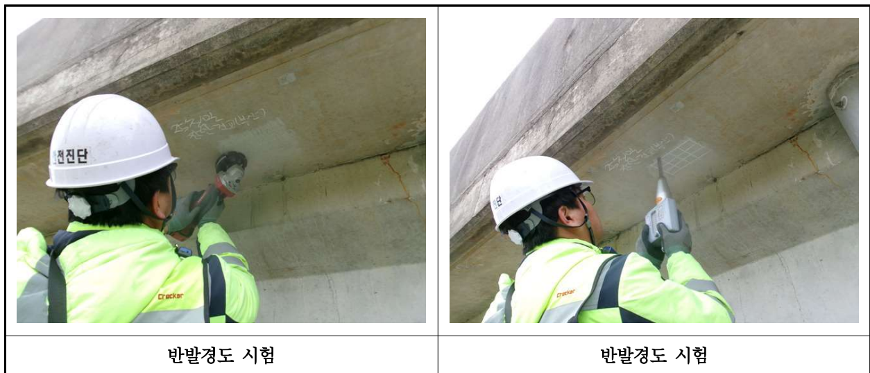
【사진 40.4.2】 반발경도시험 현장사진
