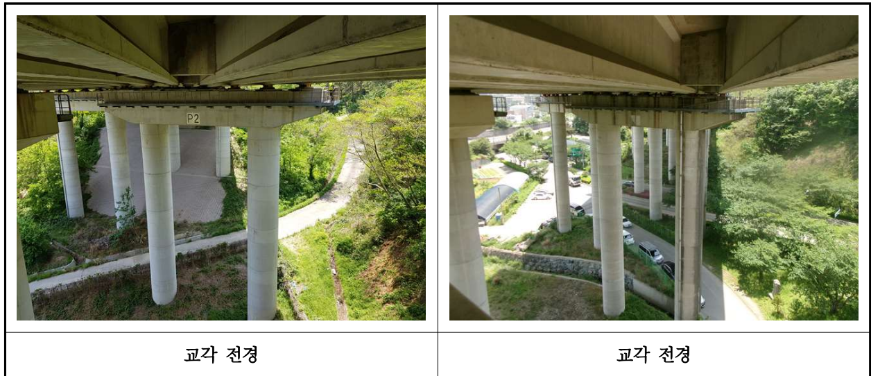
【사진 40.3.10】 교각 전경
