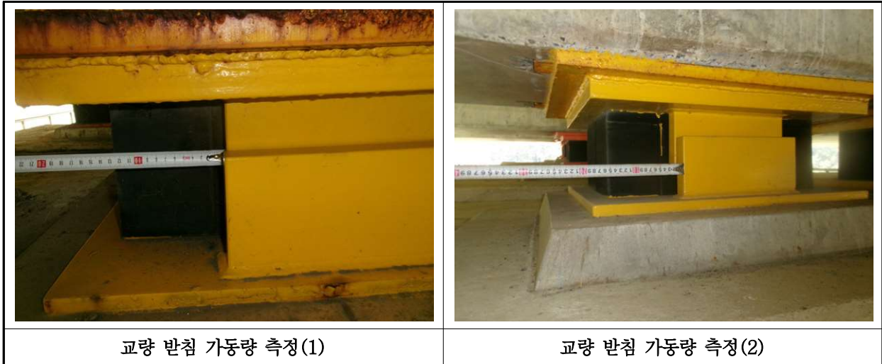
【사진 40.3.16】 교량받침 이동량 측정
