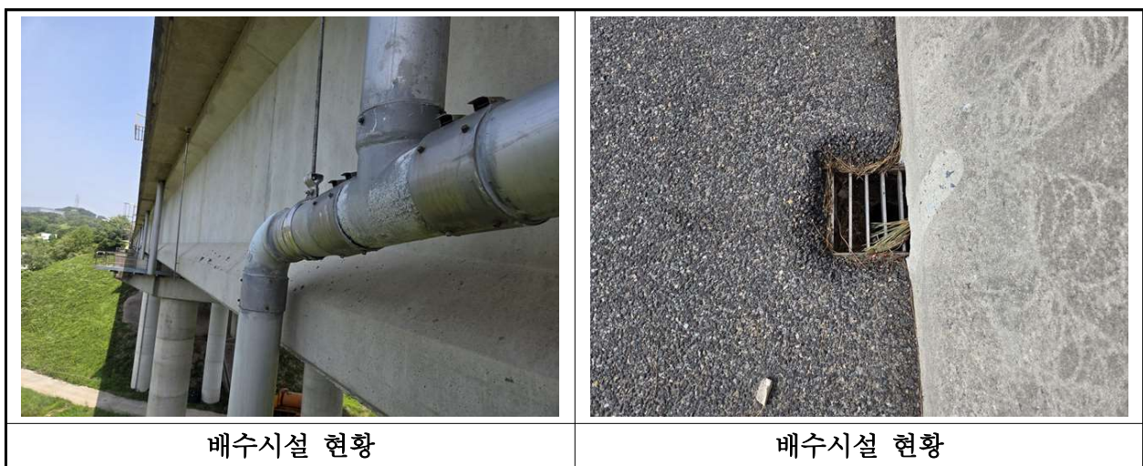
【사진 40.3.22】 배수시설 전경
