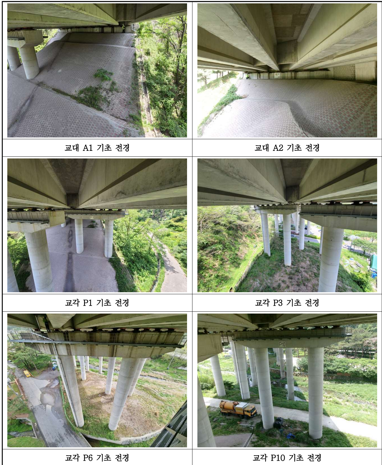
【사진 40.3.12】 기초 전경
