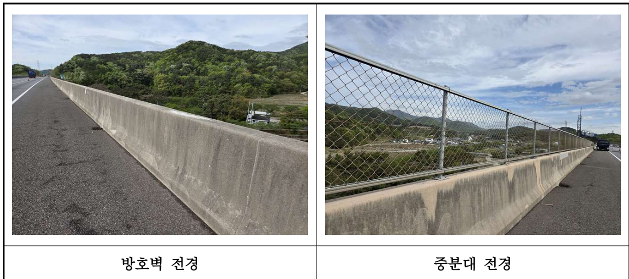
【사진 40.3.24】 방호벽 및 중분대 전경
